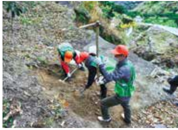
2022年12月 土の流出を防ぐための土のうを作る学生たち
