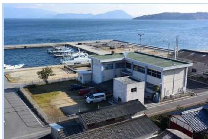
庵治マリンステーション全景
